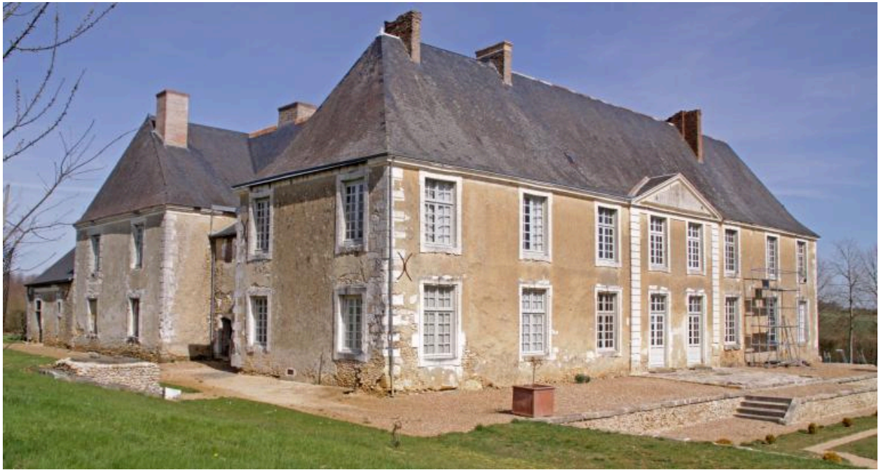
Vue de volume prise depuis le sud.
