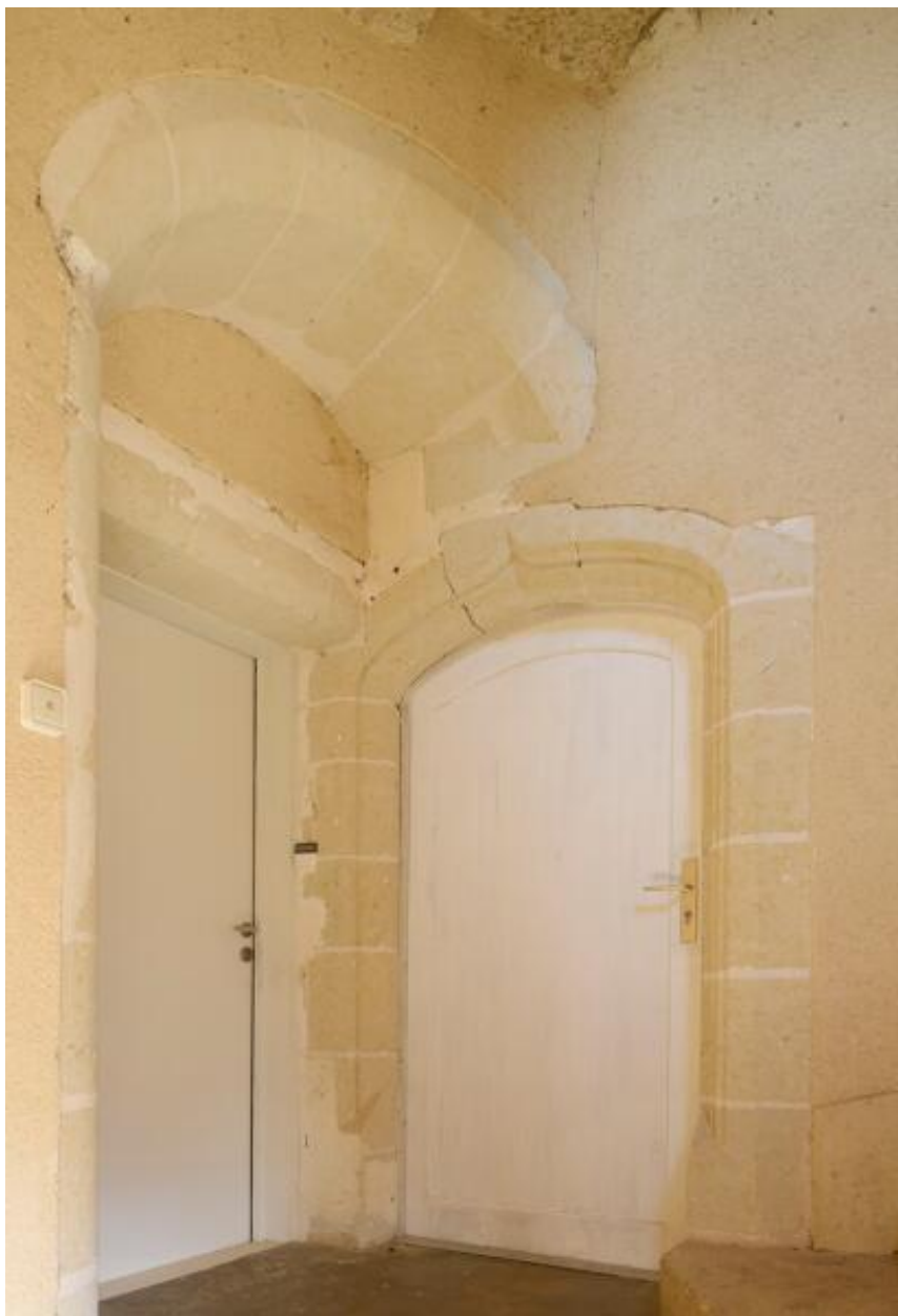
Vue des portes du premier étage ouvrant sur l'escalier.
