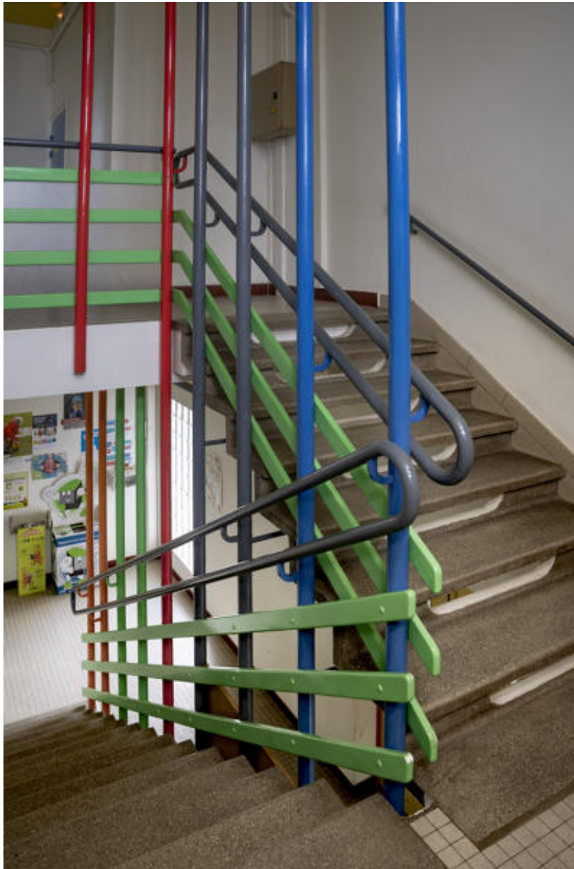
Vue de l'escalier intérieur.
