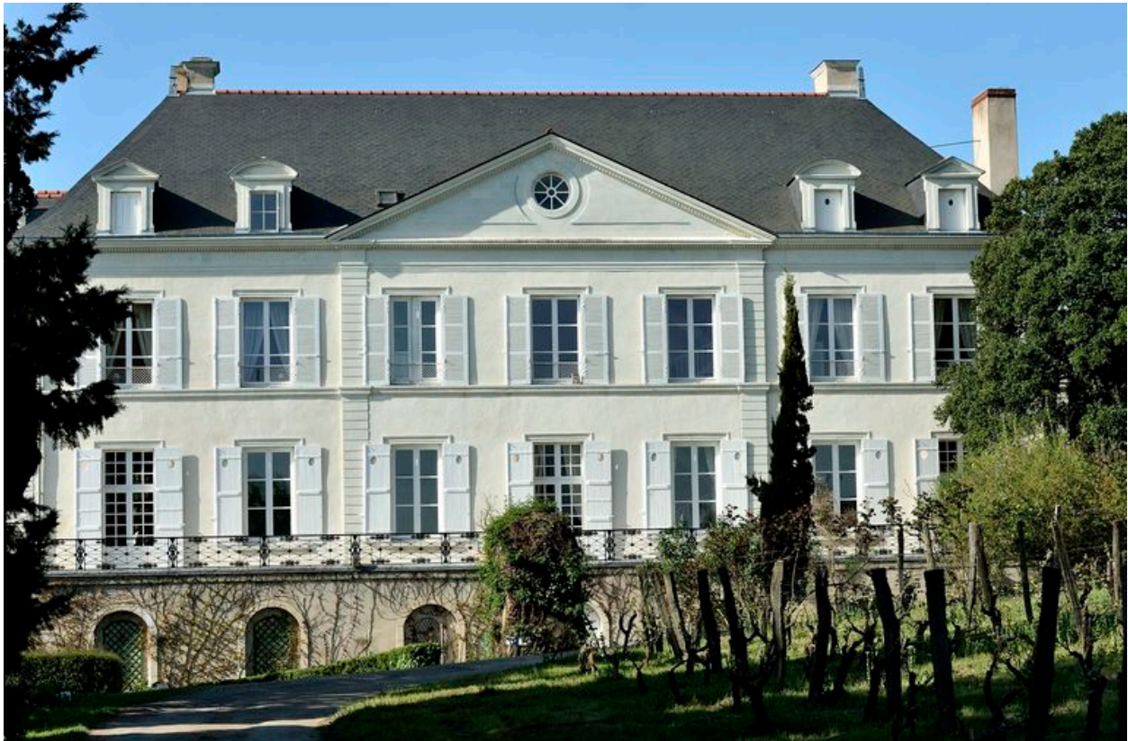
Vue de la façade nord, les vignes en premier plan.
