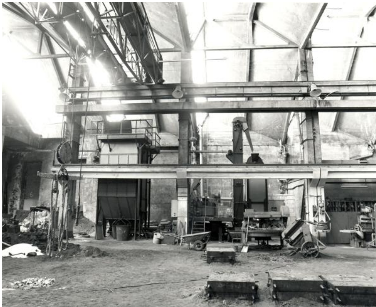
Atelier de fonderie : installation de malaxage des sables de moulage.
