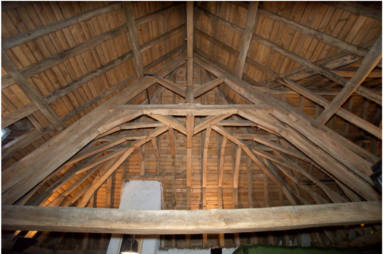
Vue de la charpente, croupe.
