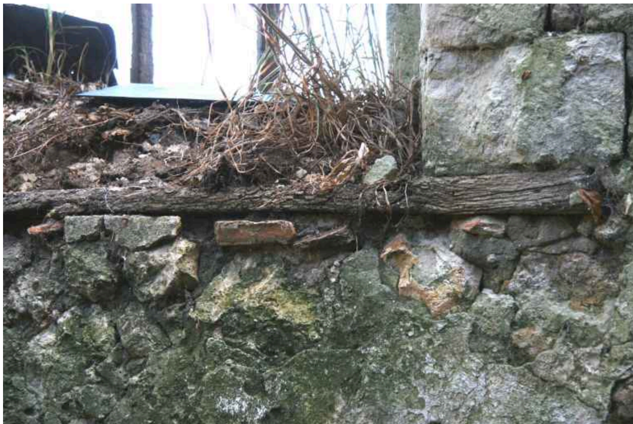
Maison n°2, façade antérieure : mise en oeuvre de l'allège de la fenêtre.
