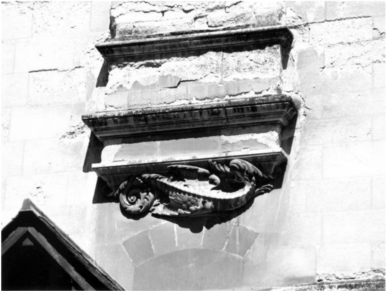
Corps de logis gauche, pignon gauche, culot du conduit de cheminée : animal fabuleux.
