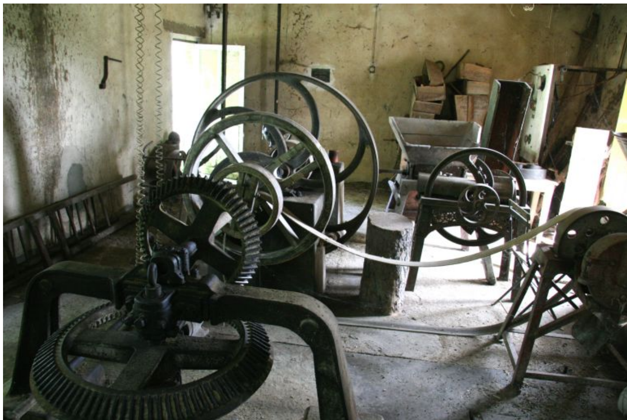
La salle des machines.
