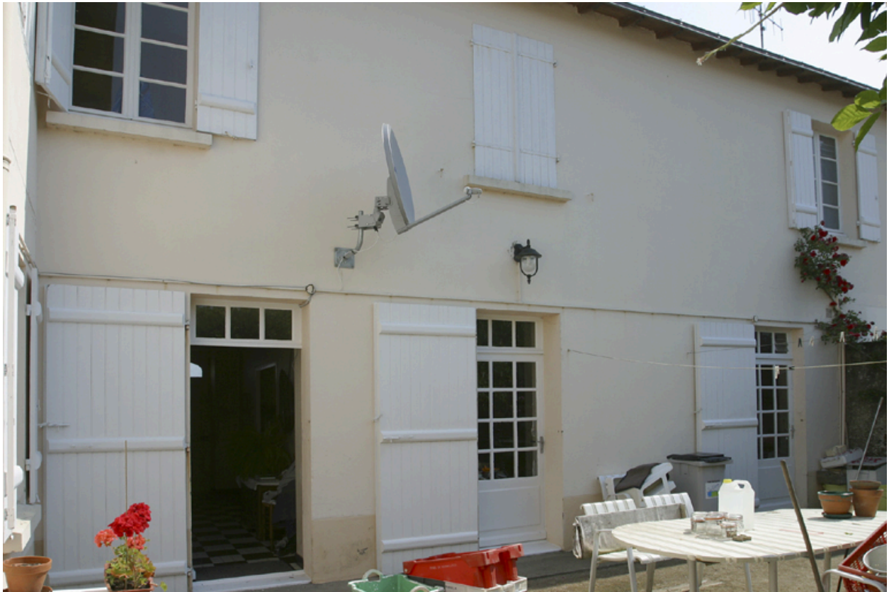
Vue partielle de la façade postérieure depuis la cour.
