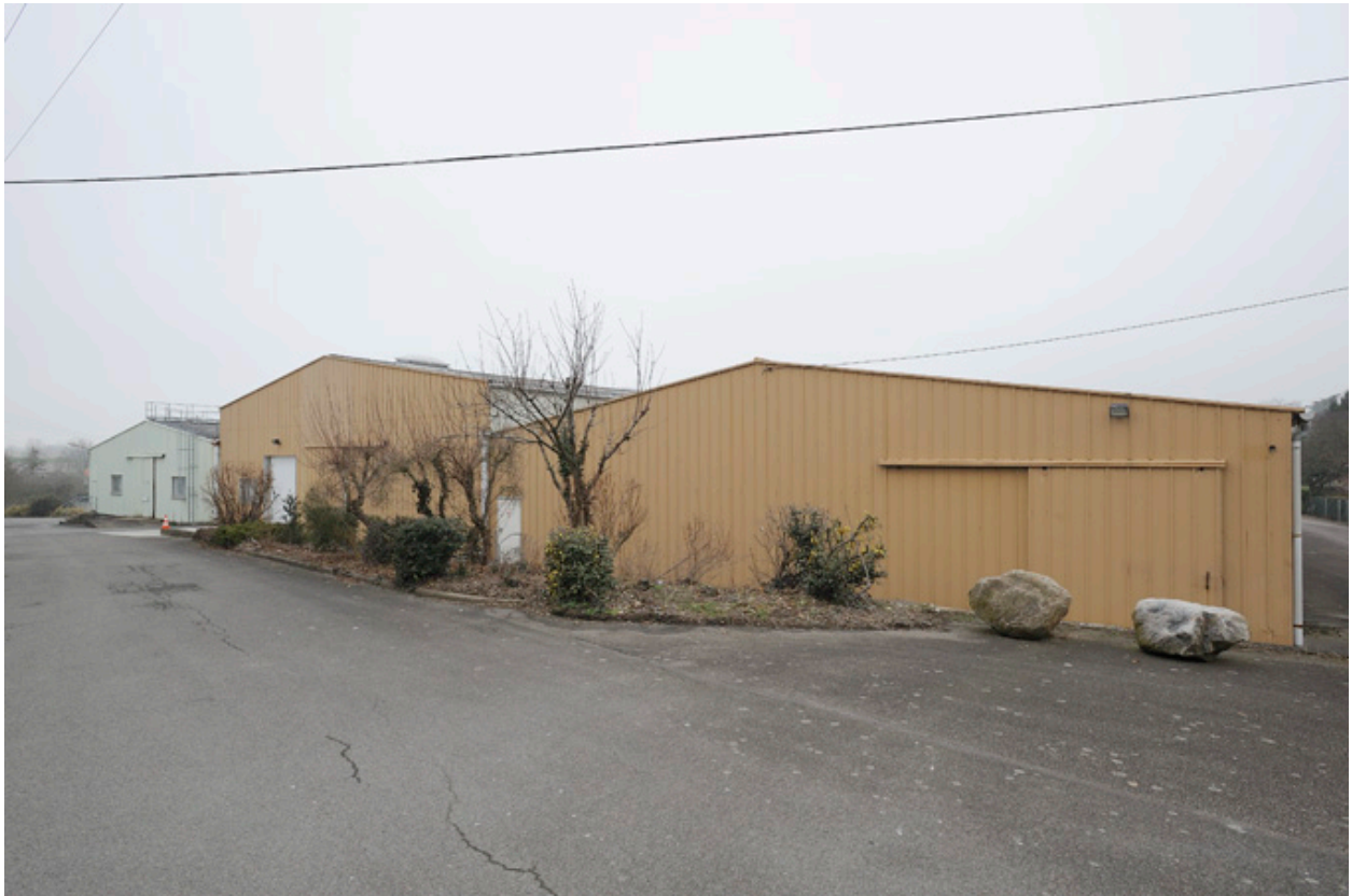
Usine Mogeco (U4), façade sud.
