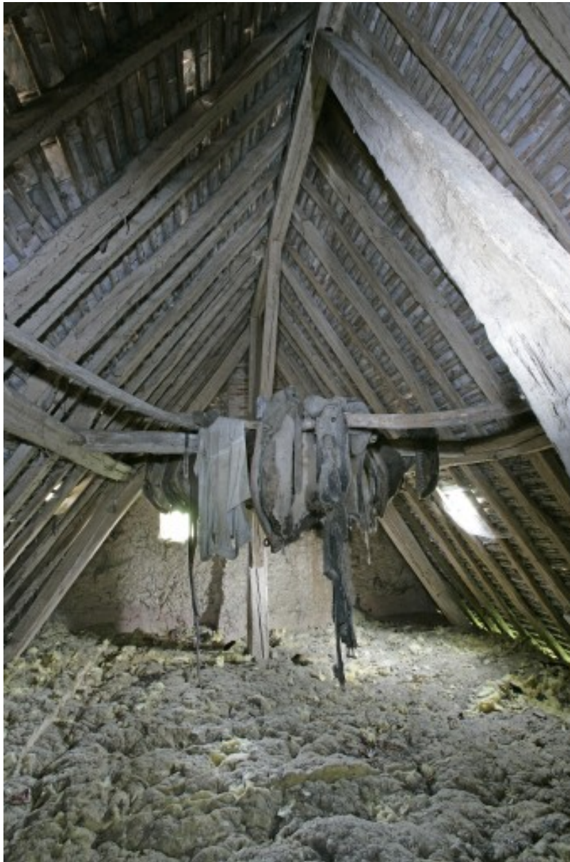
Logis, charpente de l'aile en retour : vue axiale.
