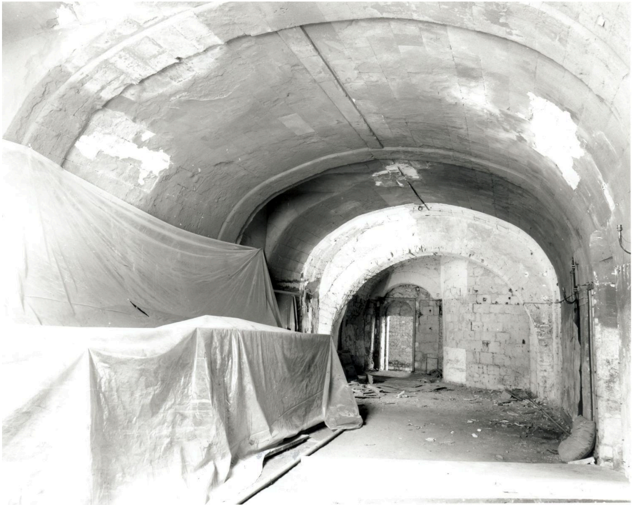
Collégiale Saint-Martin, collatéral sud du chœur, à usage de sacristie : vue d'ensemble depuis l'est vers le croisillon sud du transept.
