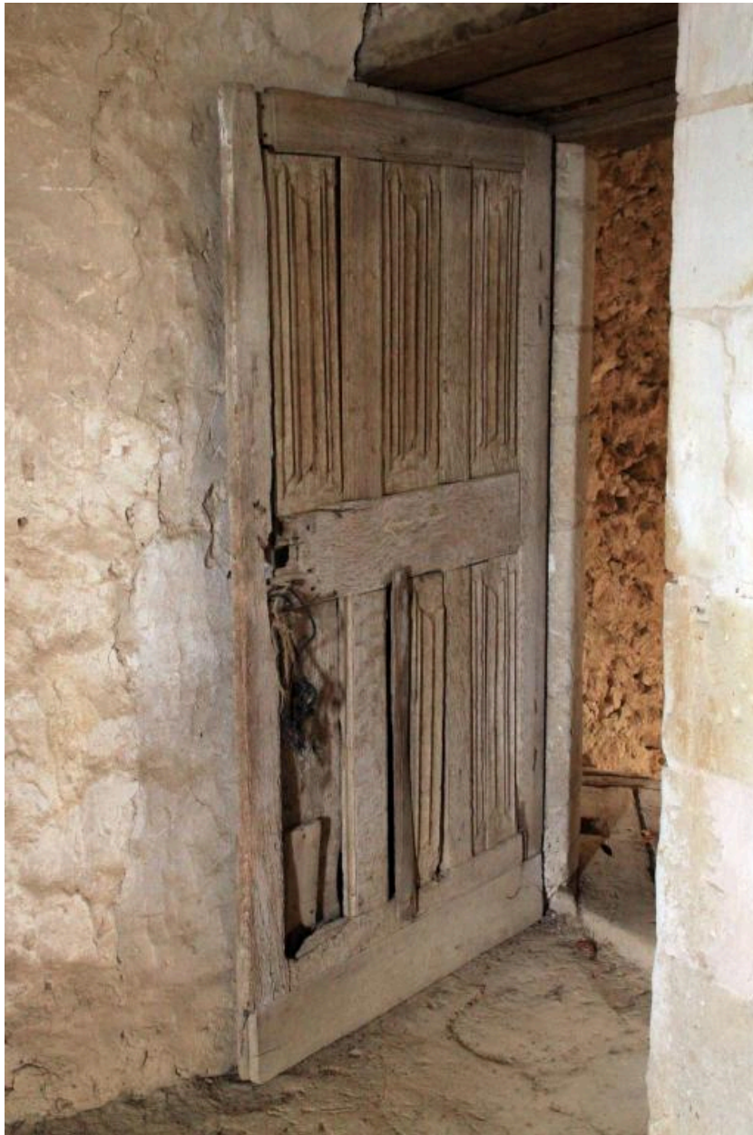
Palier du premier étage : porte de la grande salle.
