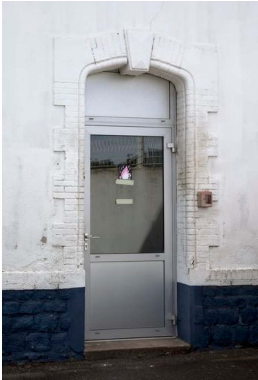
Porte de l'infirmerie, 1910.
