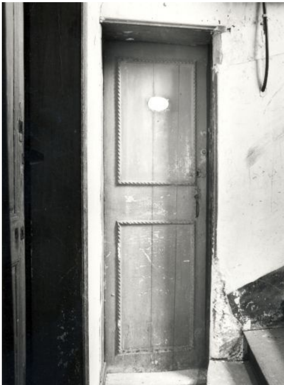
Cage d'escalier, palier du 1er étage : porte desservant les petites pièces postérieures gauche.
