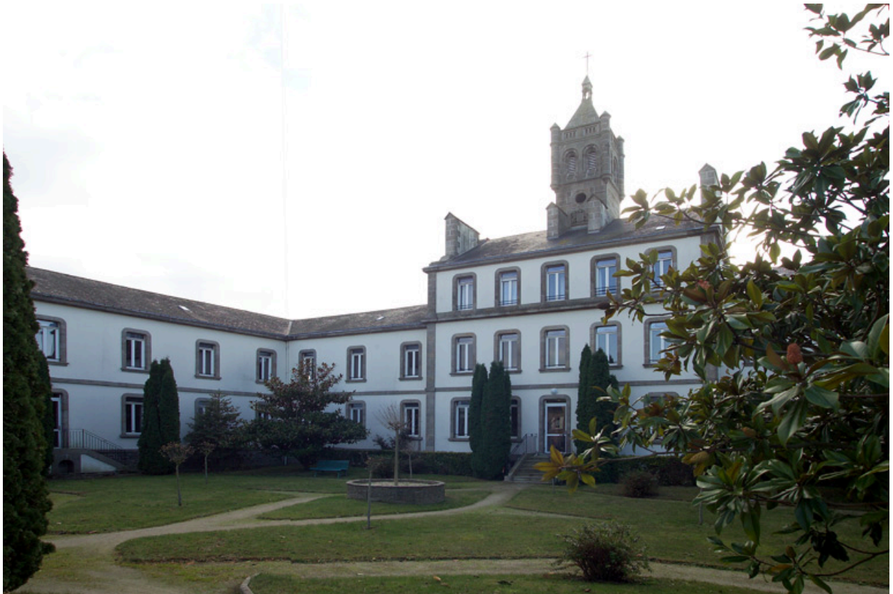
Fond de cour : corps central et aile orientale vus du nord-ouest.
