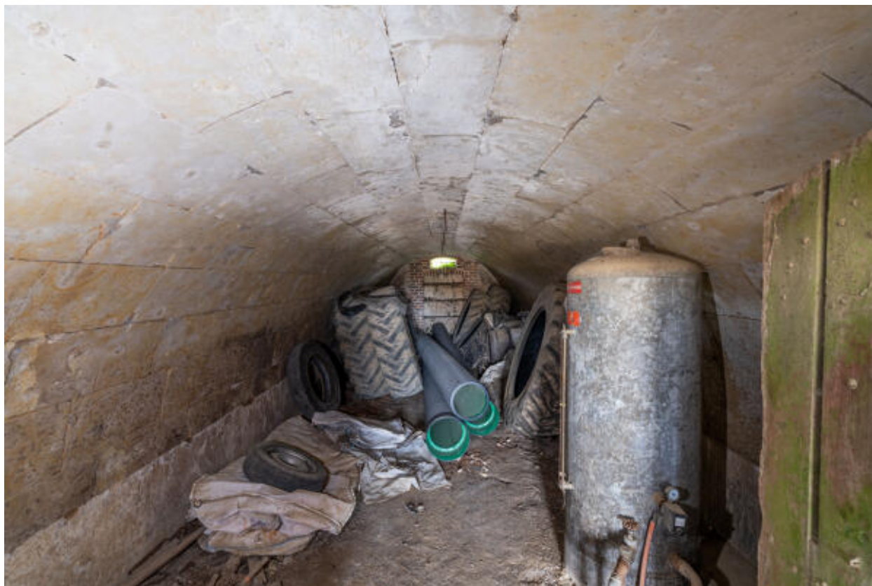
Cellier semi-enterré : vue intérieure.
