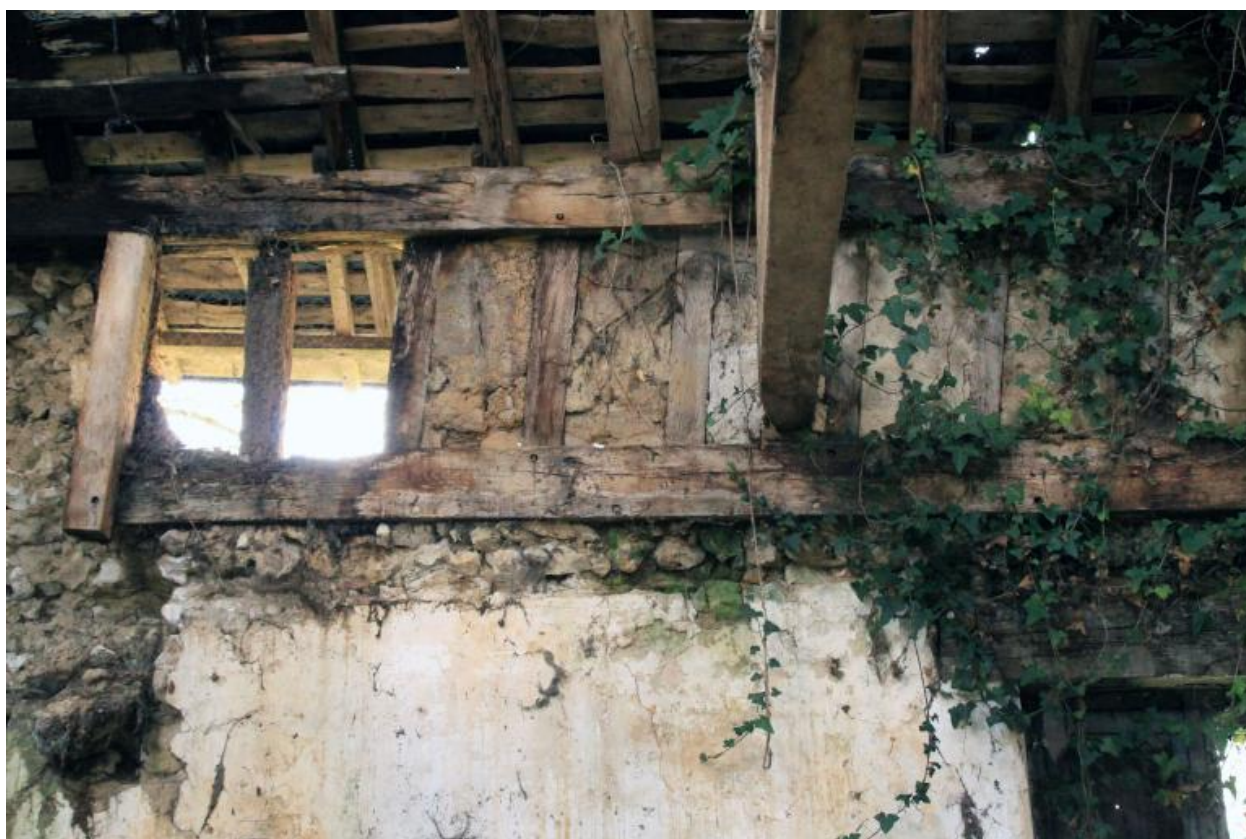
Maison 1, étage : vestiges d'un mur à pan de bois.
