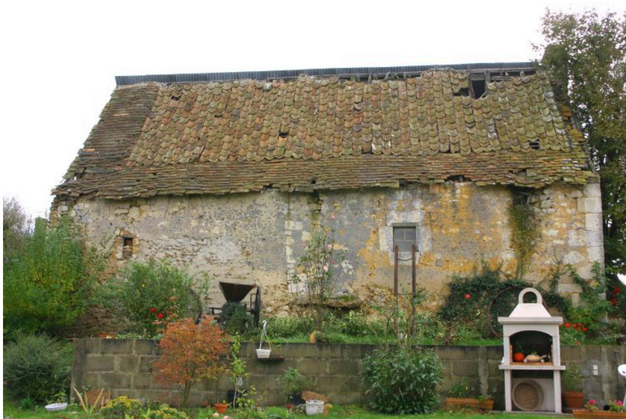
Maison 1 : façade postérieure.
