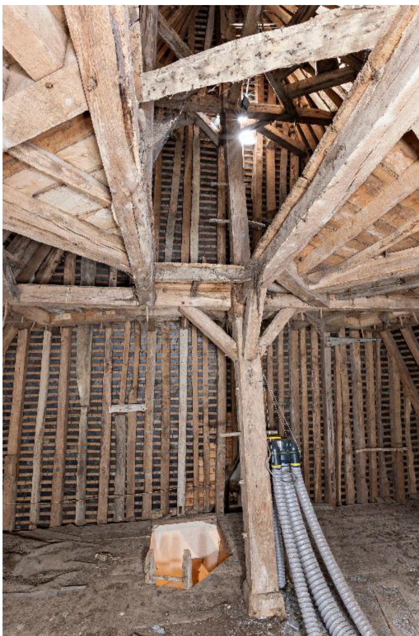
La charpente de la tour sud vue depuis le deuxième niveau côté sud.
