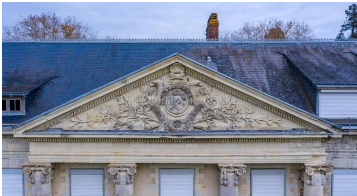
Élévation postérieure. Détail du fronton.
