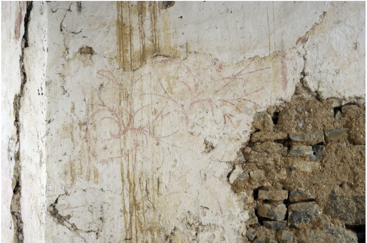
Mur sud, proximité de la fenêtre : décor végétal.
