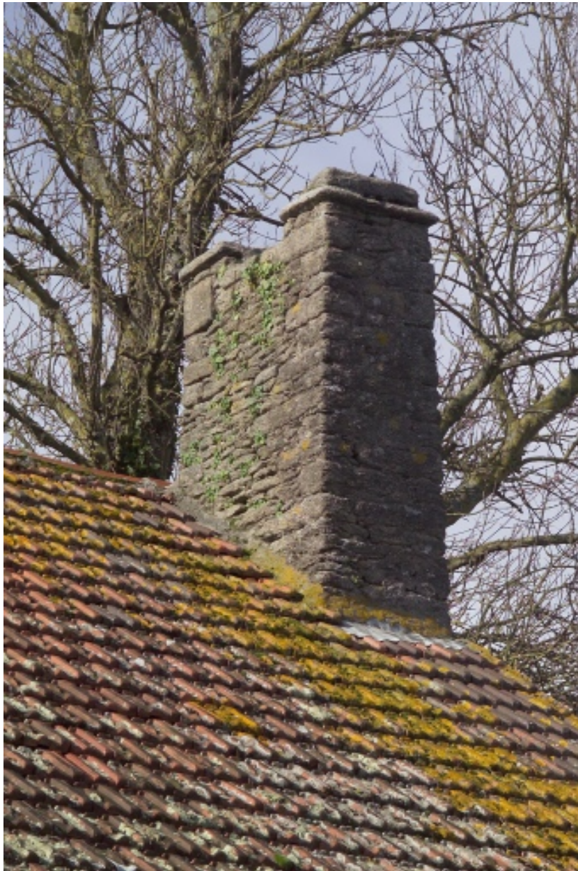
Bâtiment ouest. Vue de la souche de cheminée.
