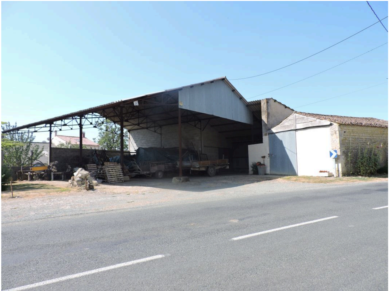
Le hangar métallique au sud de la rue, vu depuis le nord-est.
