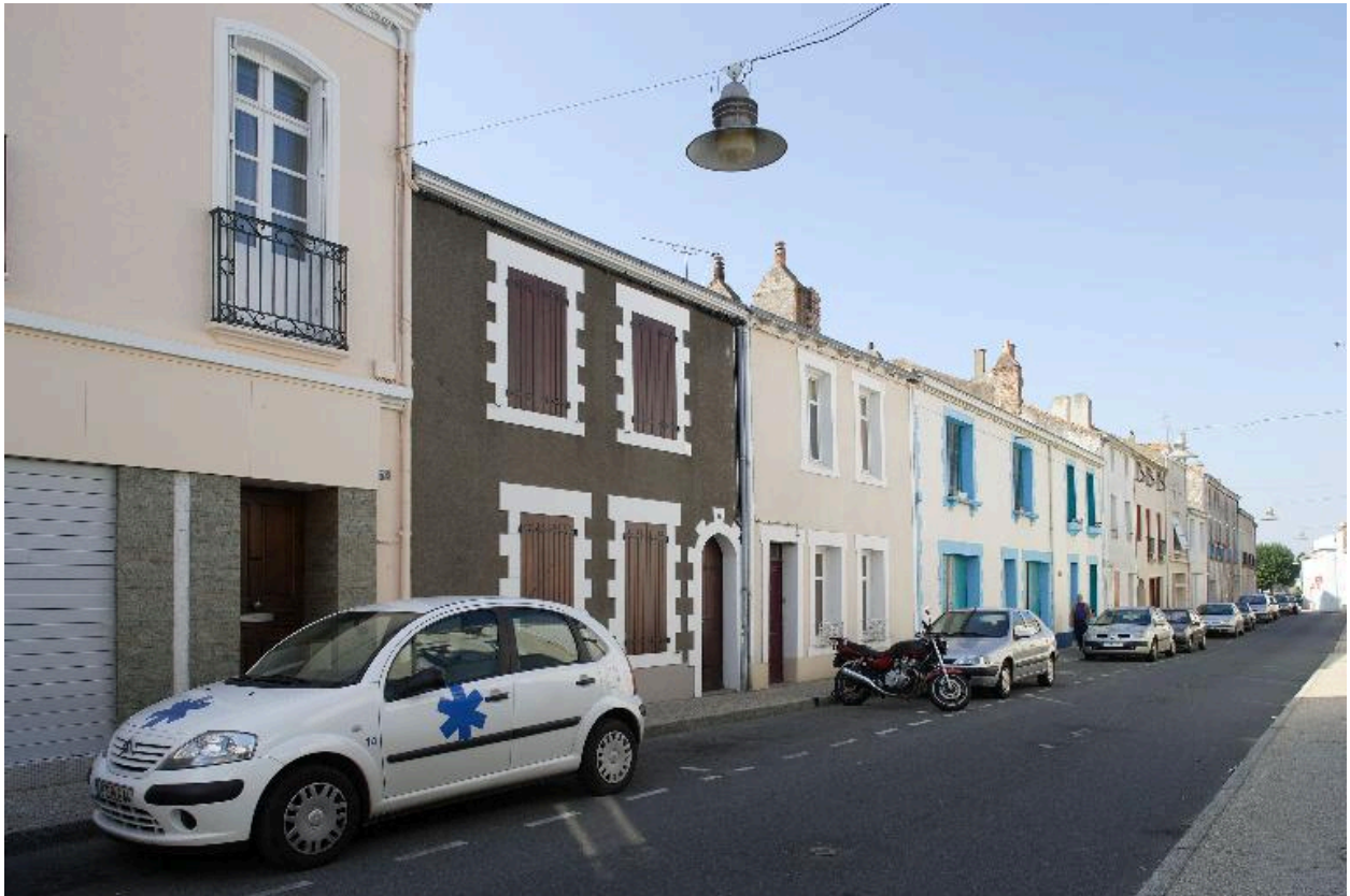
Vue d'ensemble de la face sud de la rue du Général-De-Gaulle.
