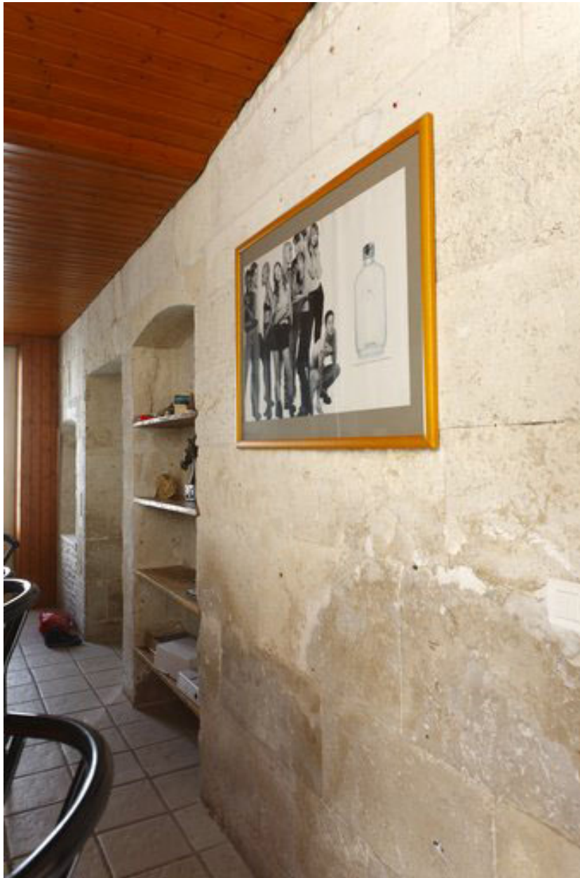
Rez-de-chaussée du n° 10 (ancienne cour de la maison précédente) : vue du mur est.
