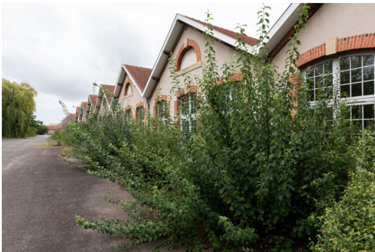
Vue d'un alignement de baraquements.
