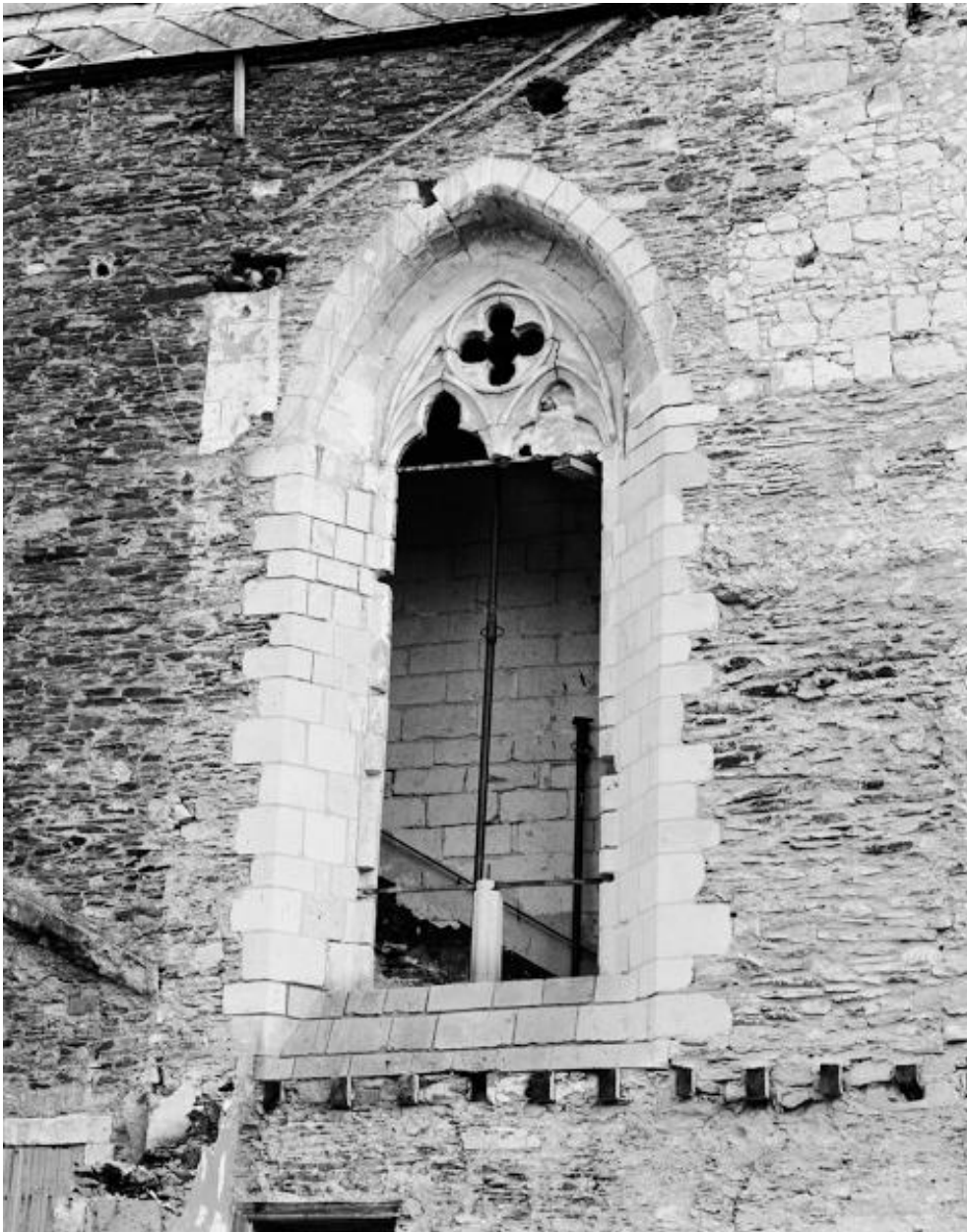
Vestige de l'église. Choeur, élévation intérieure nord : détail sur la seule fenêtre conservée.
