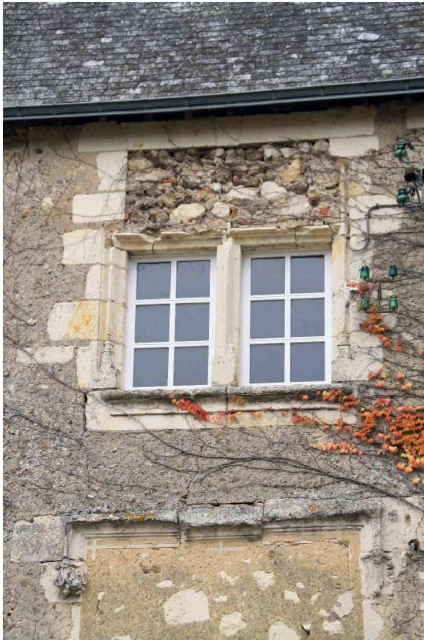
Le logis, travée de gauche, détail : croisée en pierre.
