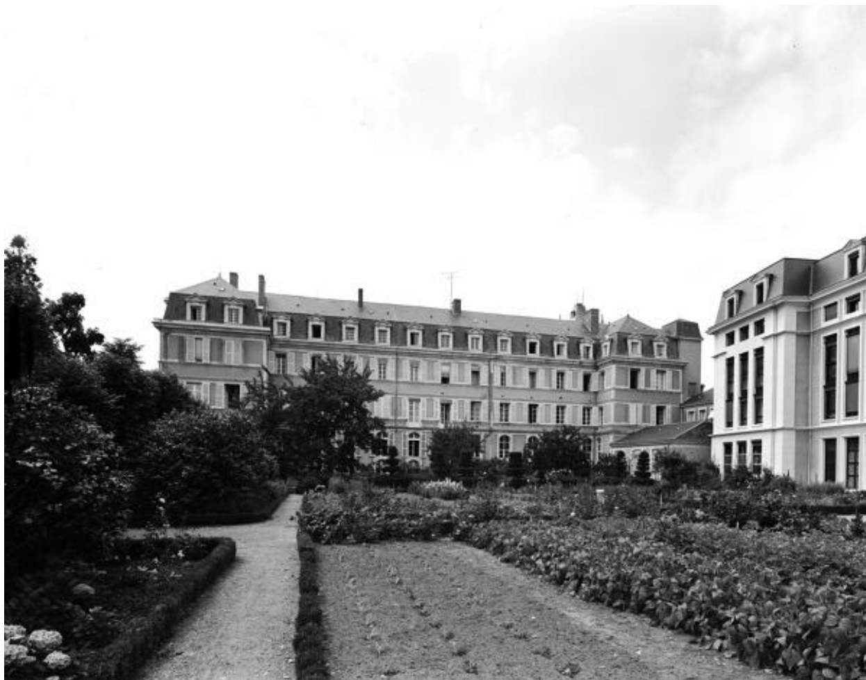
Abbaye : élévation orientale, sur le jardin potager. A droite, vue partielle du bâtiment des Archives.
