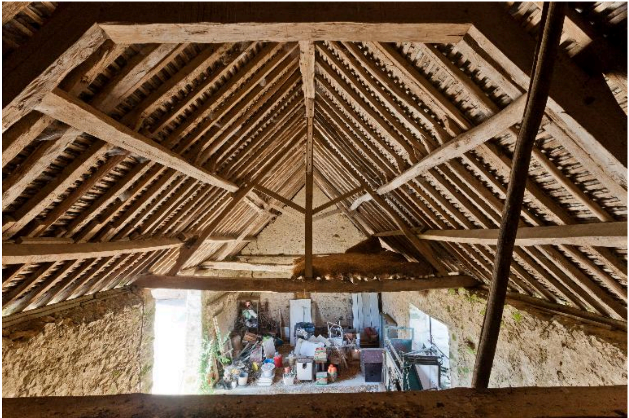
Charpente de la grange.
