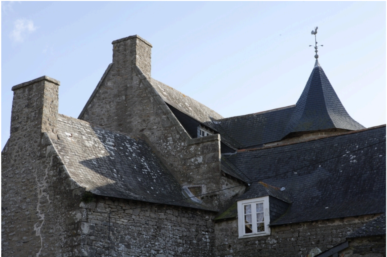
Logis. Détail des toitures depuis le nord.
