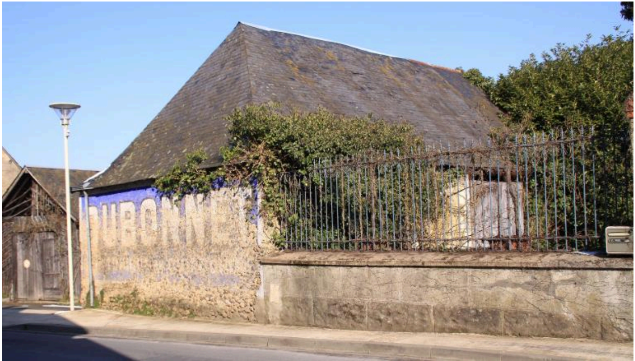
Grange, vue de volume depuis la rue.
