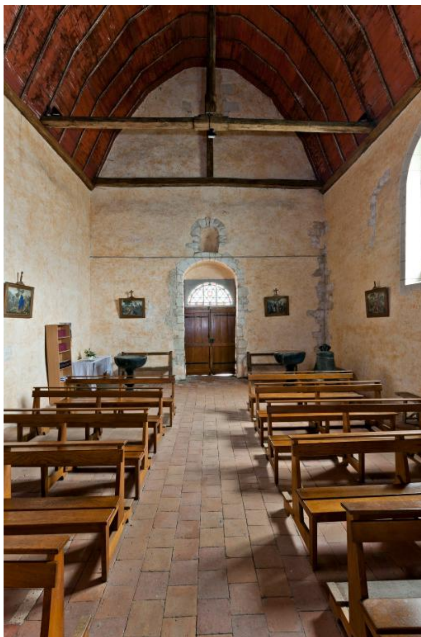
Nef vue depuis l'ouest.
