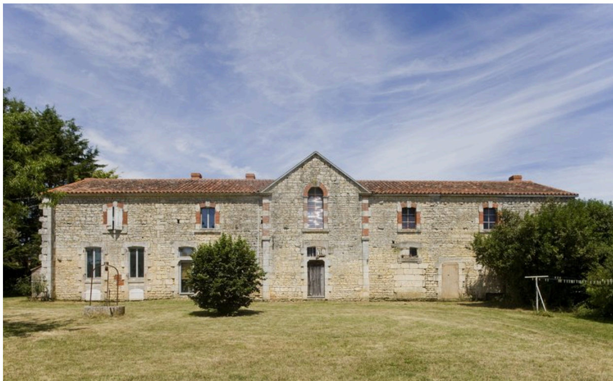
Façade sud du bâtiment sud.
