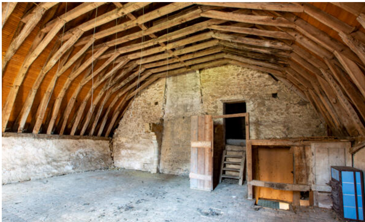
Le comble et la charpente.
