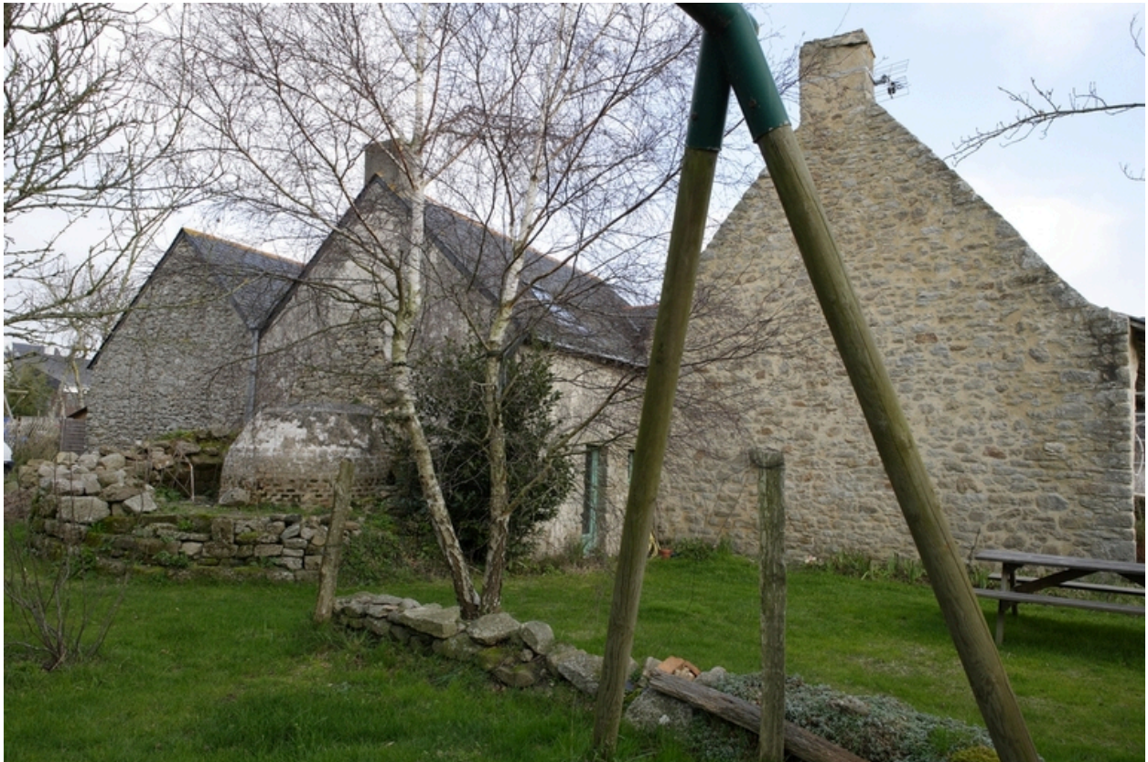
Vue du pignon du fournil.
