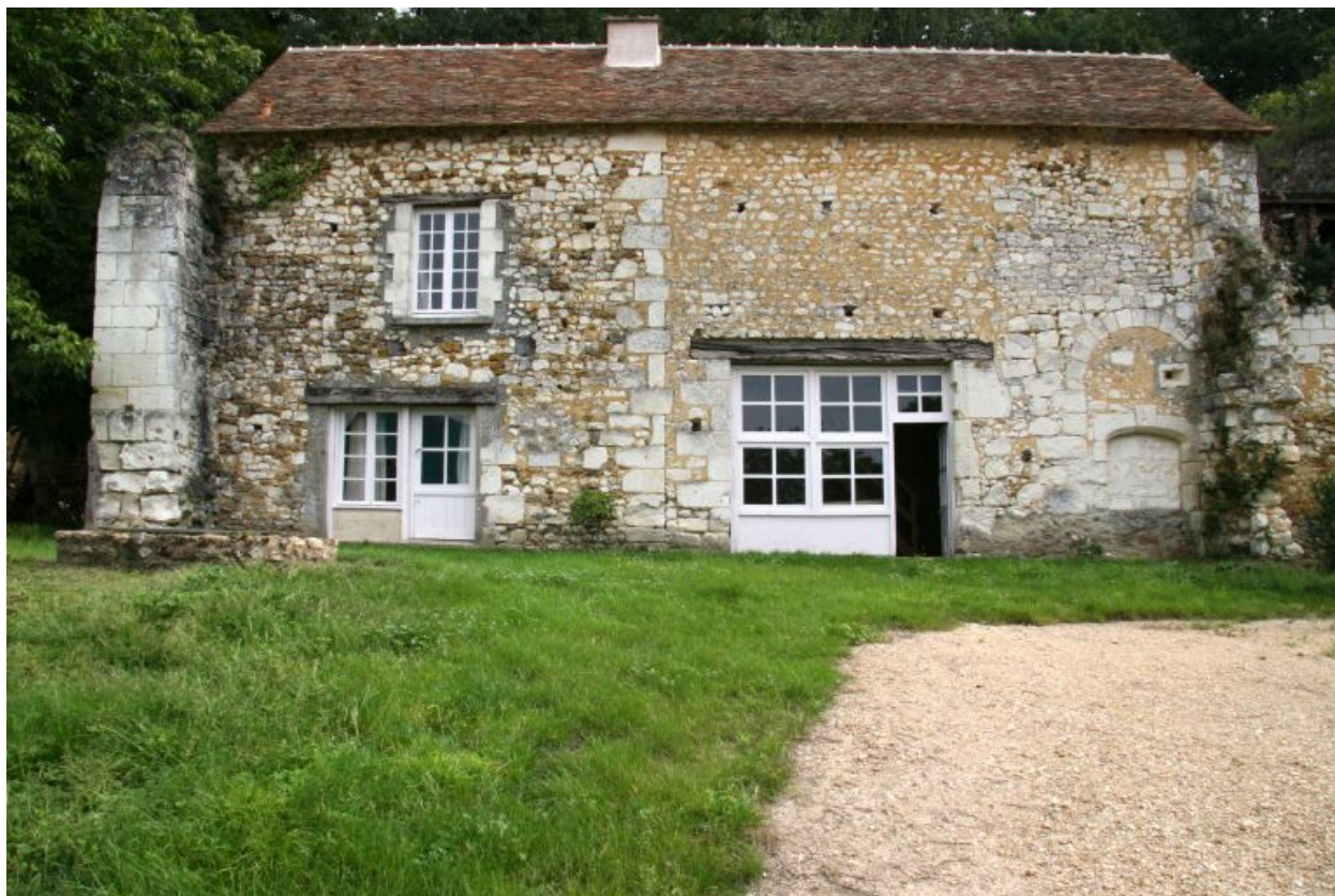
Ancien château : partie centrale très remaniée.
