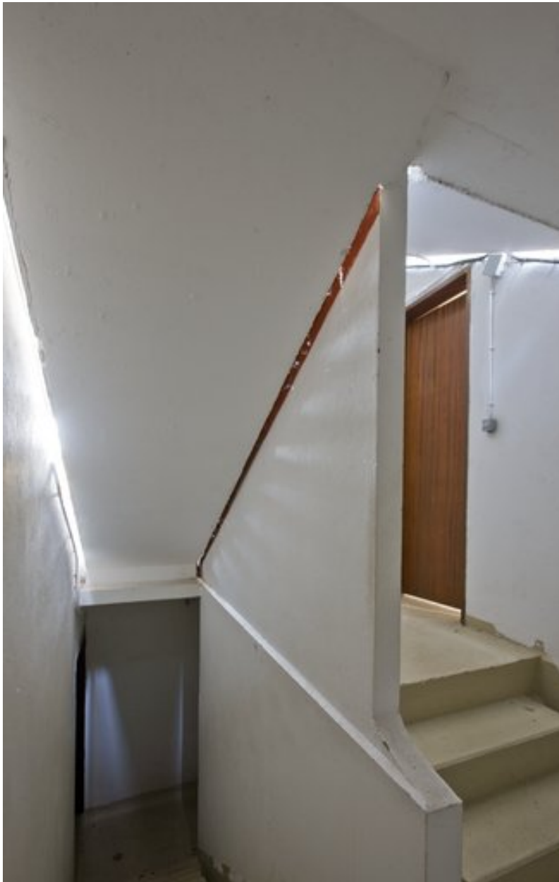
Vue de l'escalier : descente au sous-sol.
