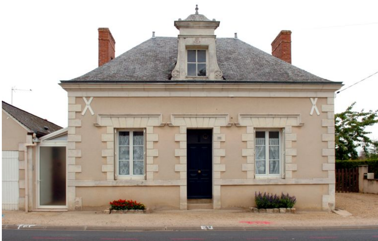
18, rue e La Flèche : maison portant la date 1913.
