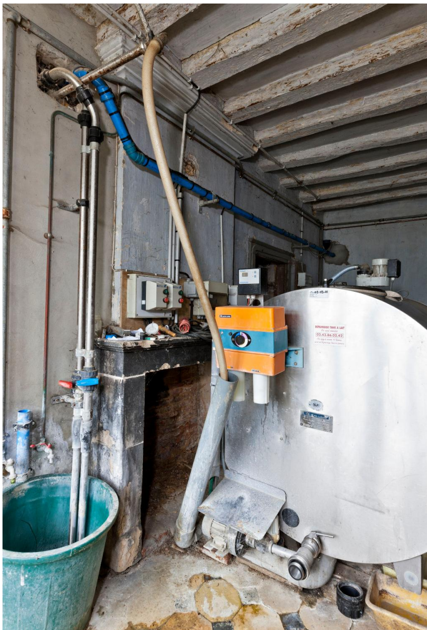
Cheminée du logement.
