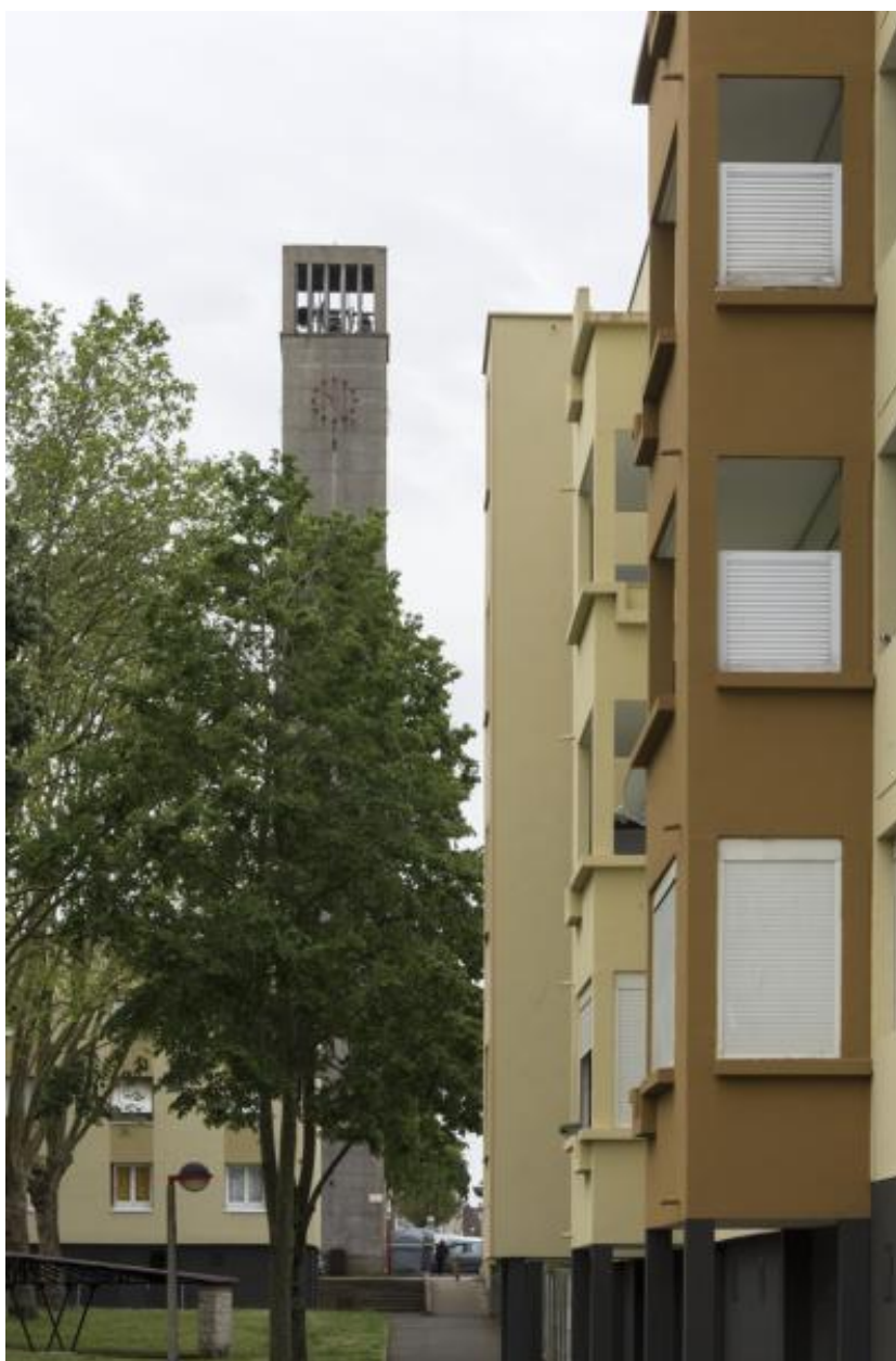
Vue du campanile depuis le Ronceray.
