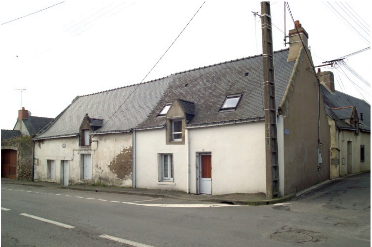
Façade sur la rue du Faubourg Saint-Armel.
