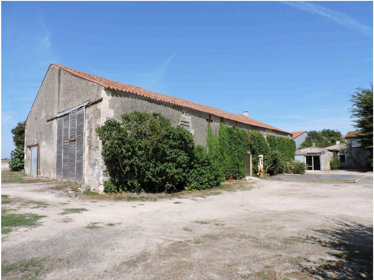
La grange-étable et la cour au sud vues depuis le sud-ouest.
