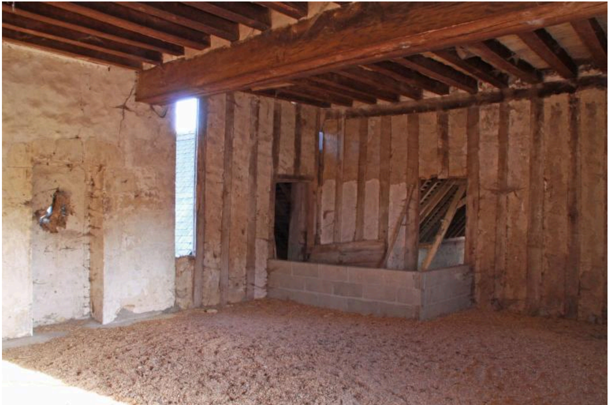
Pavillon, étage : arrivée de l'escalier.
