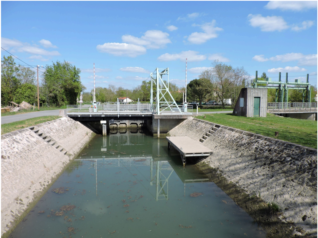
Le sas de l'écluse vu depuis l'aval.
