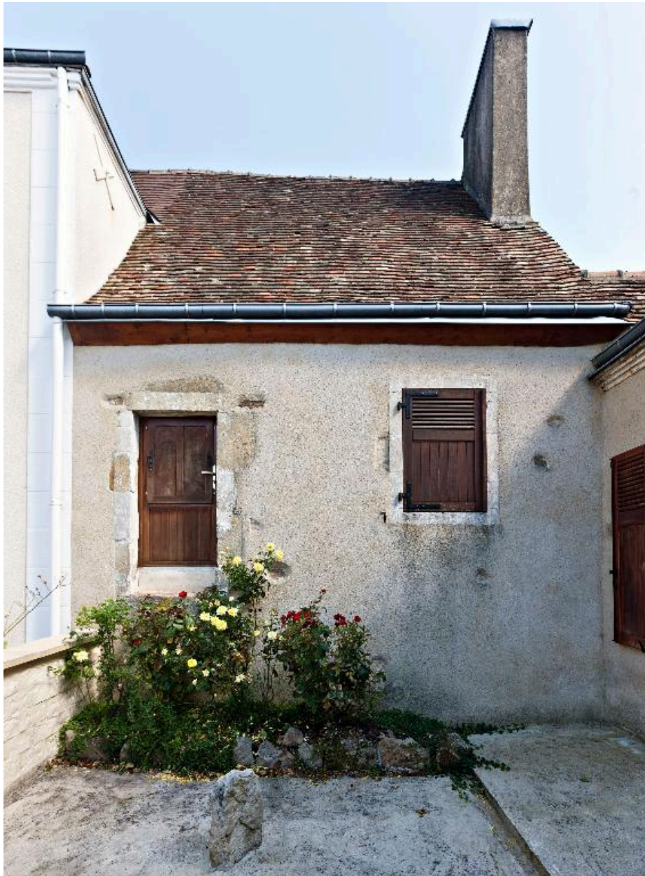
Maison de tisserand (?) à rez-de-chaussée surélevé, 9, place de l'église, construite avant 1835. La porte, à gauche, était accessible par un perron détruit.
