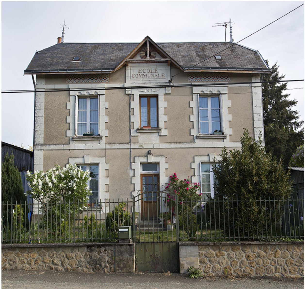
Le logement : façade côté rue.
