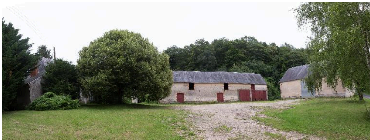
Vue d'ensemble depuis la route.
